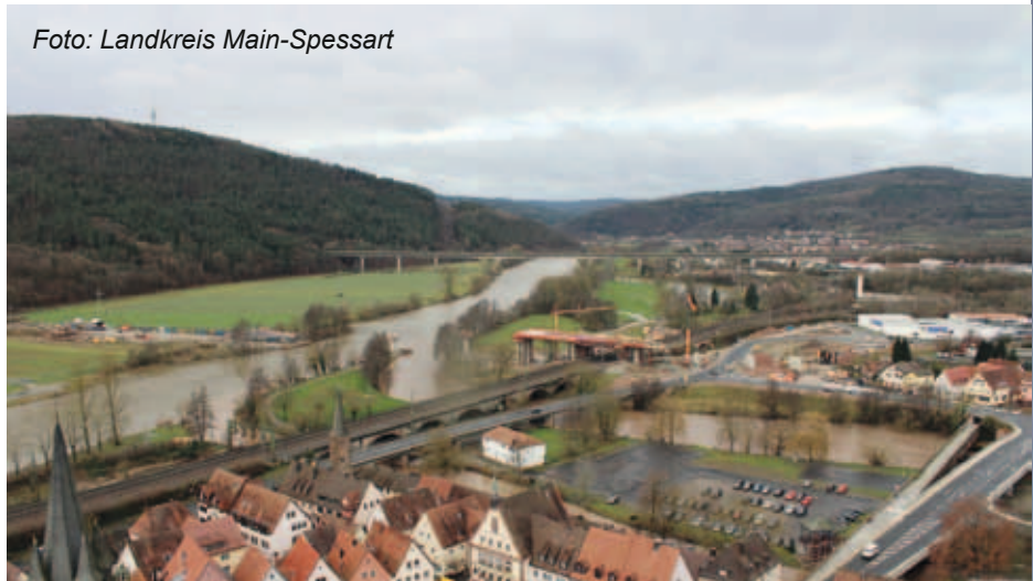
Erneuerung der Mainbrücke Gemünden a. Main
